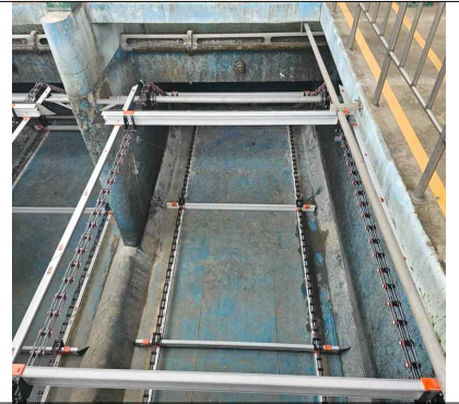
울진하수처리장 슬러지 수집기 교체 사진
