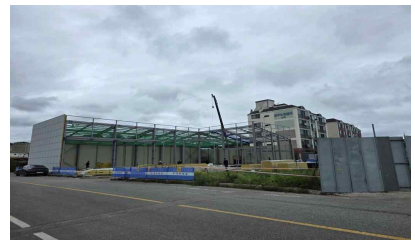
조감도, 공사 현장
