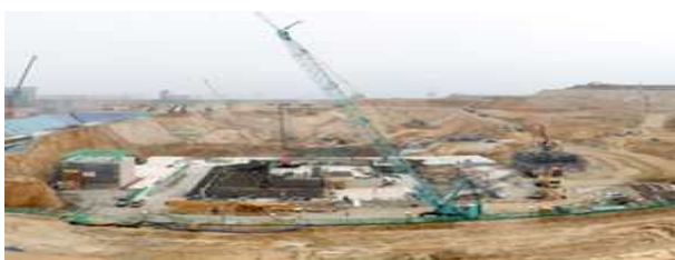
신한울 3·4호기 건설현장 전경
