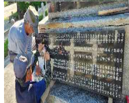
현충시설 보수 정비
