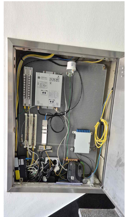
사용전 검사 (구내통신선로 설비 및 방송공동 수신설비)
